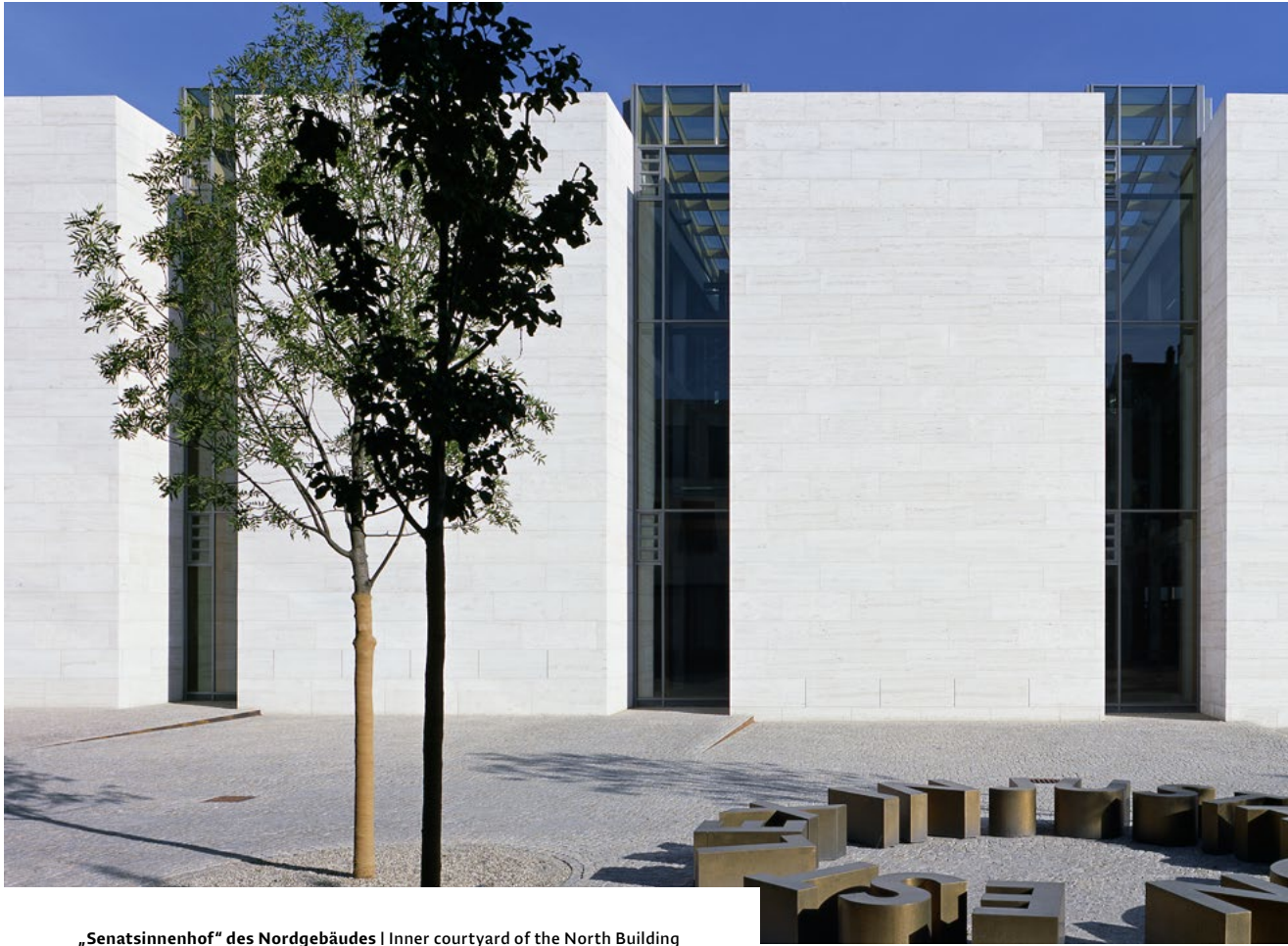
„Senatsinnenhof“ des Nordgebäudes | Inner courtyard of the North Building
